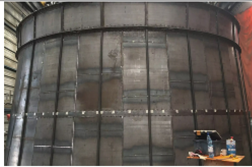
Estanques y Equipos de Proceso
